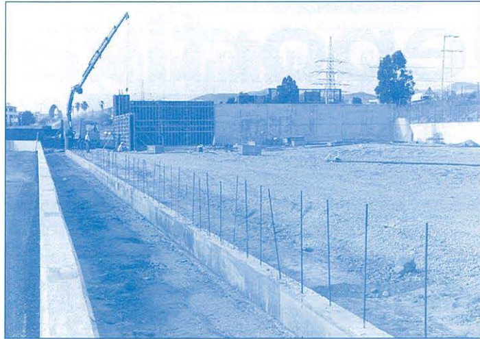
Obras de la Ciudad Deportiva
