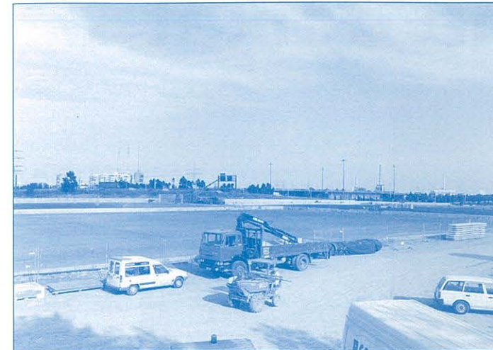
Obras de la Ciudad Deportiva
